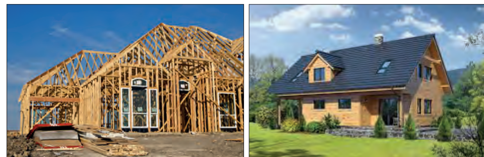
Ryc. 8. (od lewej) Konstrukcja domu szkieletowego, dom szkieletowy, źródło: http://www.quebec.huffingtonpost.ca , http://www.housege.ru
